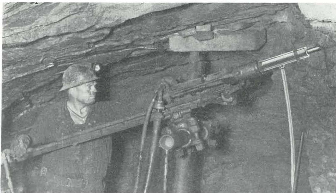
Fig. 20. — Supermarteau Ingersoll-Rand équipé pour la foration de trous de reconnaissance
