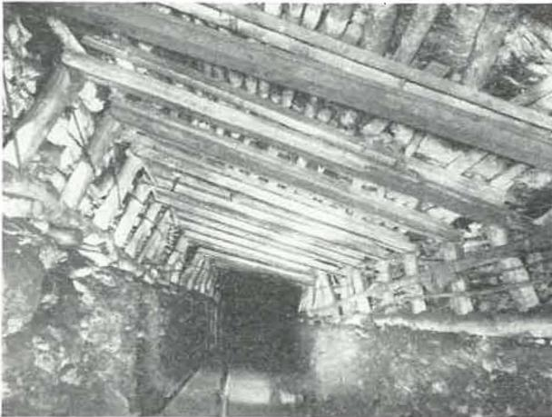
Fig. 5. — Vue du tronçon boulonné et du soutènement postiche servant à prévenir une chute massive éventuelle. Le toit s'est affaissé d'environ 50 cm, ce qui a réduit la distance entre les fers U et les portiques à 10 ou 20 cm.
