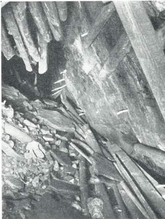
Fig. 5. — Vue du tronçon boulonné après retrait du soutènement. Le toit a conservé sa cohésion et n'a subi qu'une faible flexion (La prise de vue est inversée — La paroi boulonnée est à droite).
