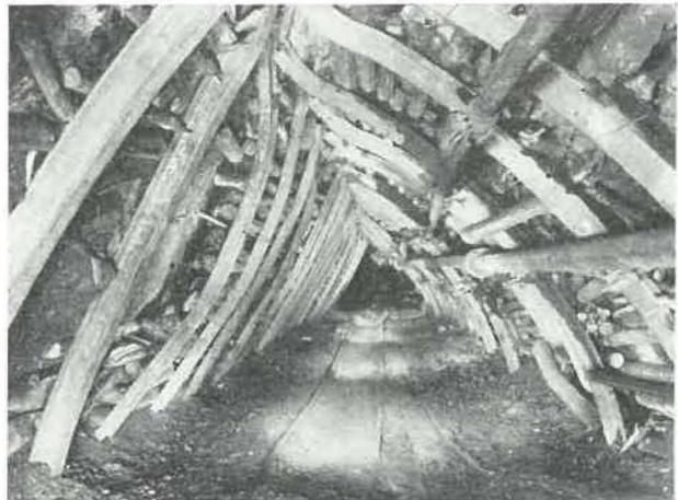
Fig. 2. — Couche Wilhelm. Aspect du tronçon boulonné après le passage de la taille. On voit à l'avant plan deux cadres avec rails de 5 mètres non boulonnés. Au delà, les rails ont été remplacés par des fers U boulonnés (la paroi boulonnée est à gauche). Les rails et les premiers fers U à l'avant-plan ont fléchi. Les autres fers U ne sont que faiblement déformés.
