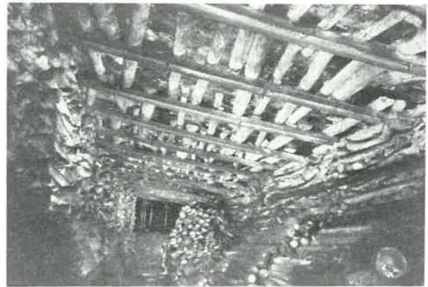
Fig. 6. Vue du tronçon boulonné après l'abandon du soutènement postiche.
