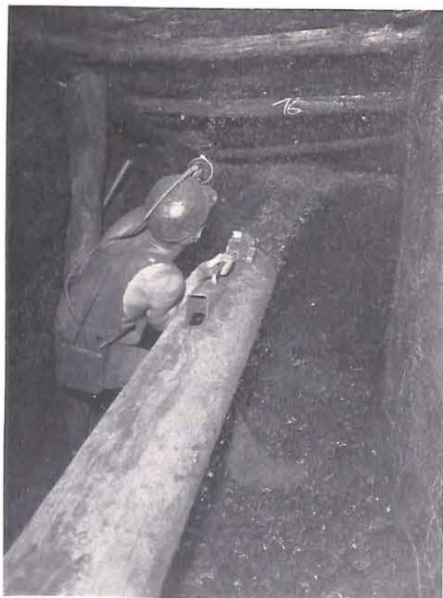
Fig. 6. — Sortie des remblais au pied de la canalisation.
