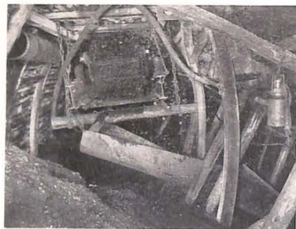
Fig. 5. — Amenée des remblais en tête de taille par convoyeur métallique.
