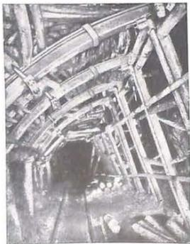
Fig. 9. — Soutènement Lorenz H.H. (L.T.H.)
