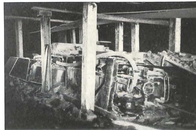
Fig. 8. — Alimentation de la remblayeuse Anderson Boyes par convoyeur à courroie à brin inférieur porteur.
