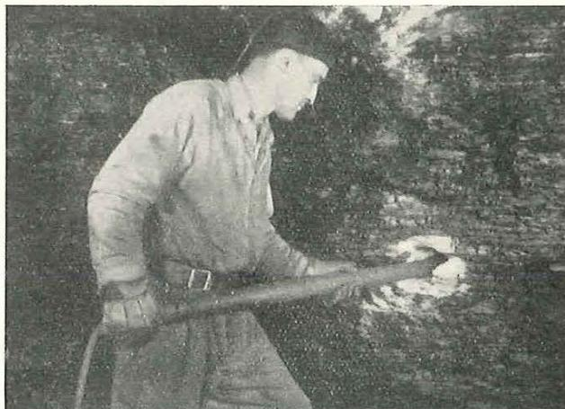
Fig. 3. — Placement de l'élément dans le trou de mine.
