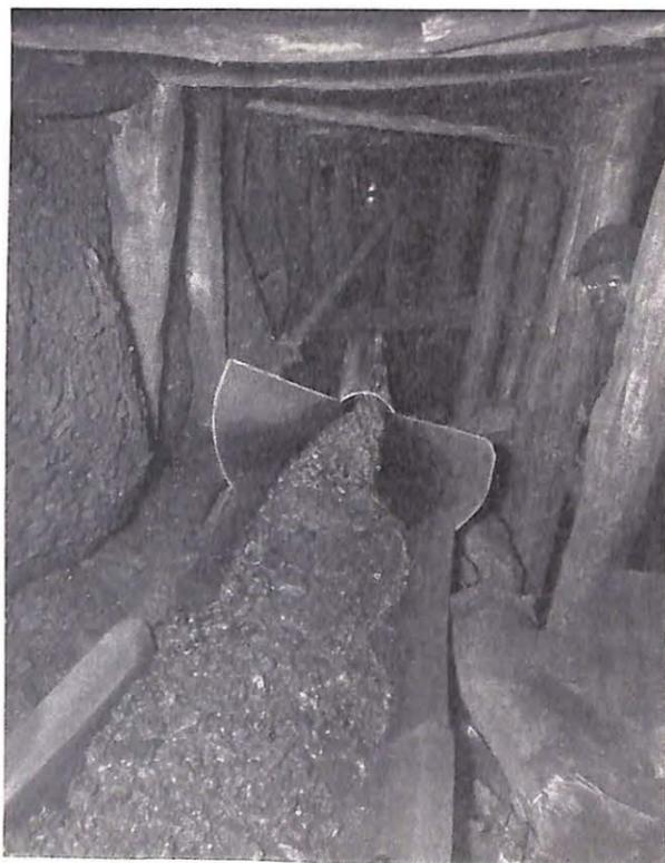
Fig. 5. — Entonnoir en tête de la canalisation de remblayage par coulée.
