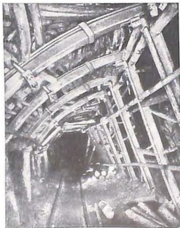
Fig. 9. — Soutènement Lorenz T.H. (L.T.H.)
