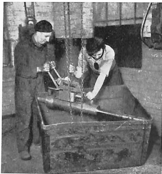
Fig. 7. — Extenseur pour la reformation des caisses de berlines.
