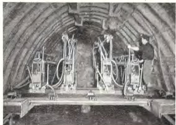
Fig. 9. — Chariot de forage Mönninghoff pour chargement avec duck bill.
