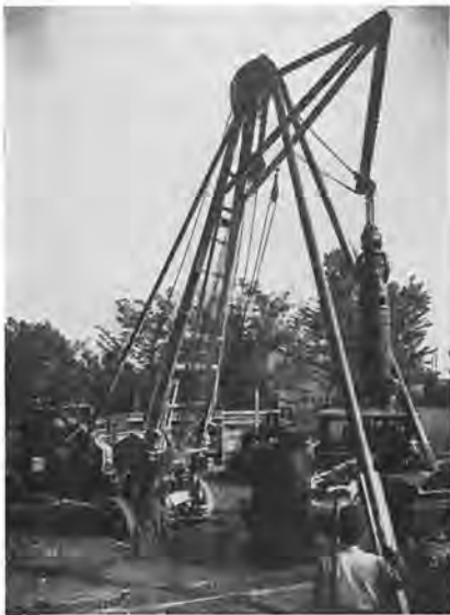
Fig. 15. — Matériel de forage pour forage par le procédé Benoto,
