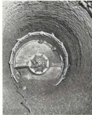
Fig. 5. — Vue de la tête de forage avec le cône central.
