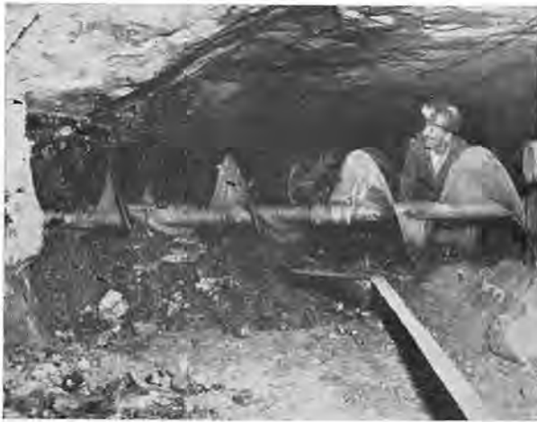
Fig. 4. — Couloir en forme de bec de canard pour l'évacuation du charbon rejeté par la tarière.
