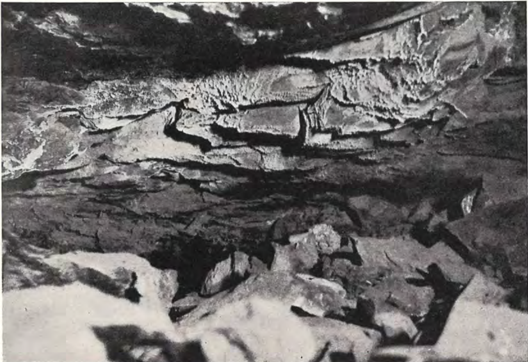
Fig. 3. — Chantier II de Bois-La-Dame. — Eboulis dans la zone épuisée.
