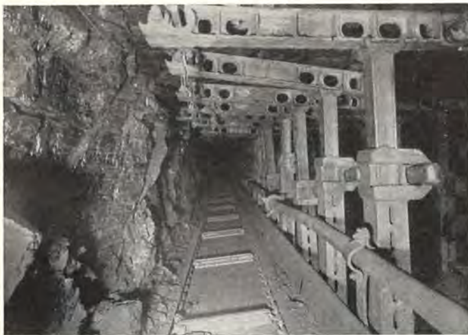
Fig. 15. — Chantier équipé de bèles Belgam II. Charbonnages de Monceau-Fontaine (siège n. 18).
