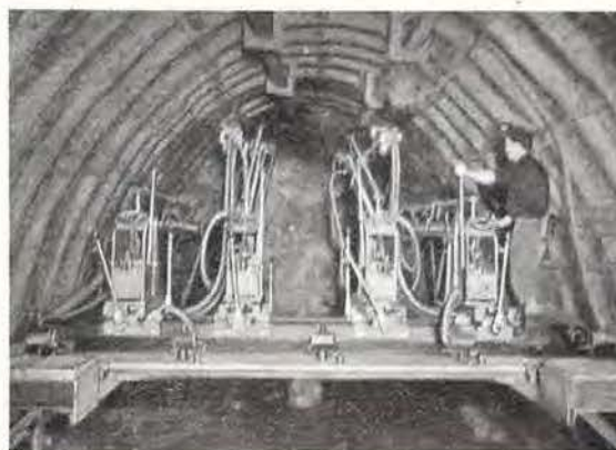
Fig. 9. — Chariot de forage Mönninghoff pour chargement avec duck bill.
