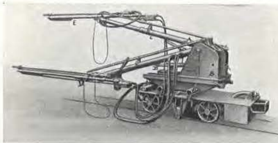
Fig. 8. — Chariot de forage Mönninghoff.
