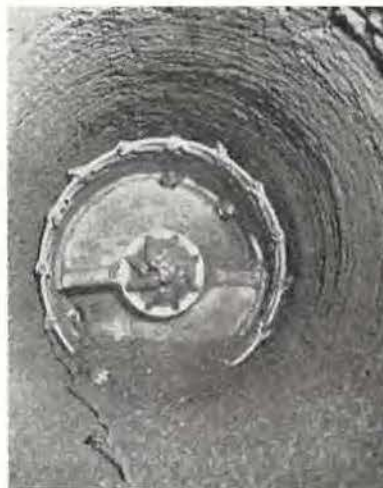
Fig. 3. — Vue de la tête de forage avec le cône central.
