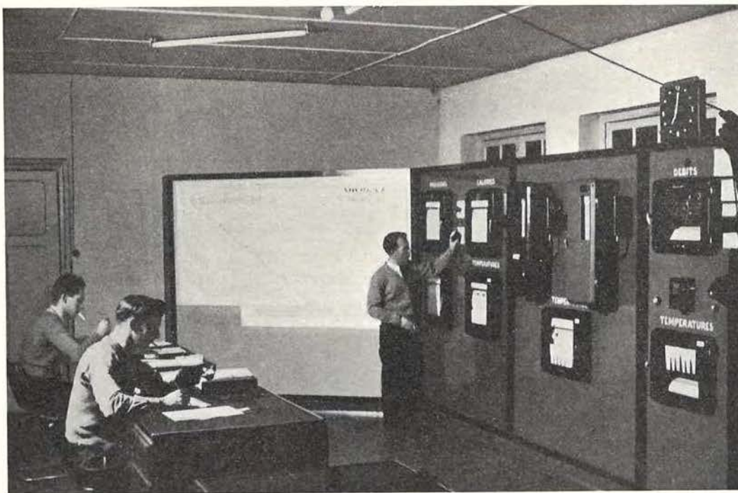
Fig. 12. — Vue partielle de la station de mesure.
