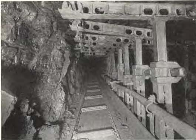
Fig. 15. — Chantier équipé de bèles Belgau II. Charbonnages de Monceau-Fontaine (siège n. 18).
