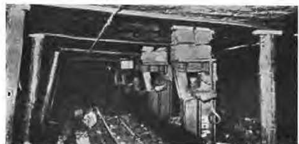
Fig. 25. — Les piles Mainsforth en place le long du convoyeur.
