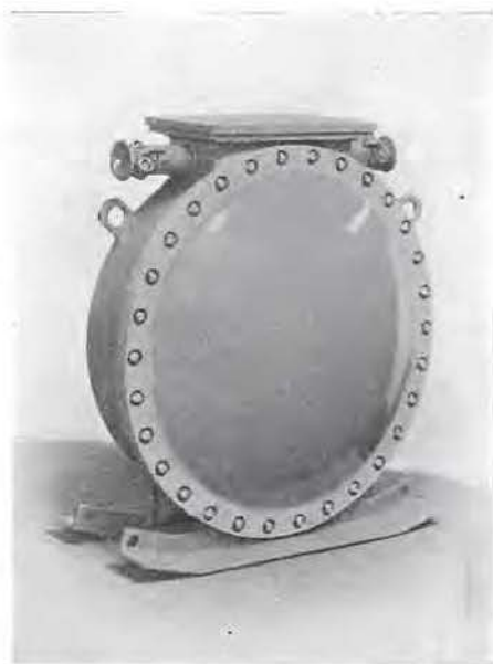
Fig. 29. — Transfo éclairage Siemens.
