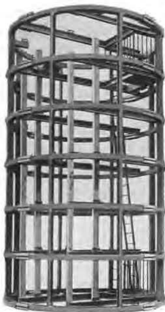
Fig. 4. — Cadres métalliques pour burquins (système Hoffmann).
