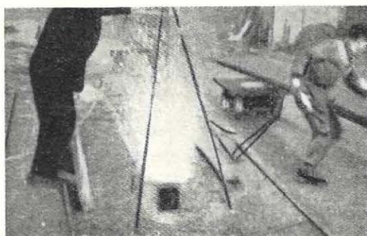
Fig. 5. — La lance en fonctionnement, gerbe d'étincelles.
