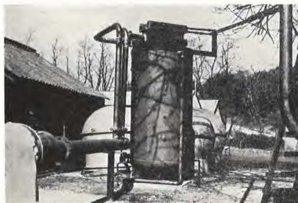
Fig. 7. — Evaporateur d'oxygène.
