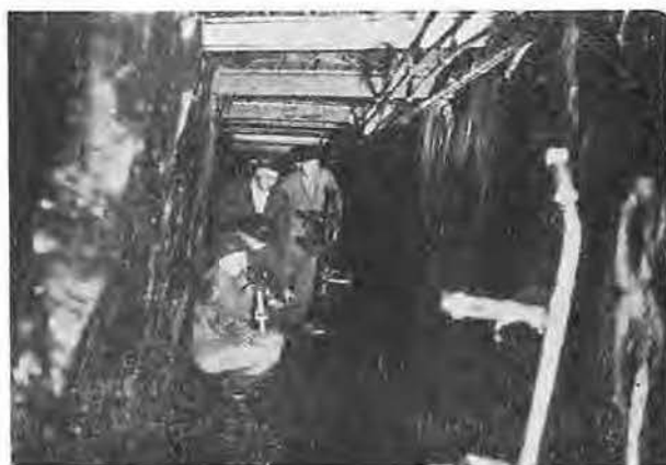
Fig. 5. — Galerie de base du chantier.
