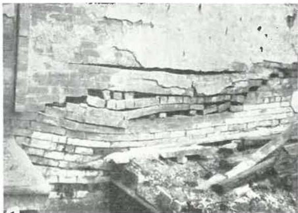
Fig. 4. — Dégradations d'une partie de mur dus à des efforts de cisaillement.
