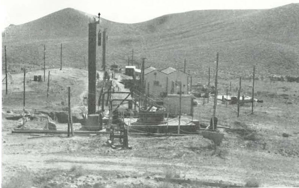
Fig. 5. — Vue d'ensemble du chantier.
