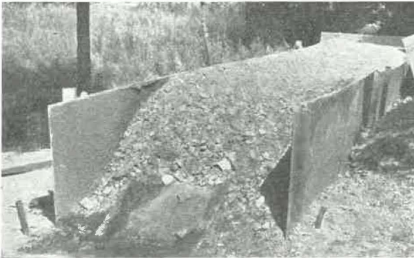
Fig. 2. — Remblai édifié en surface avec la machine. remarquez le degré de compaction obtenu.
