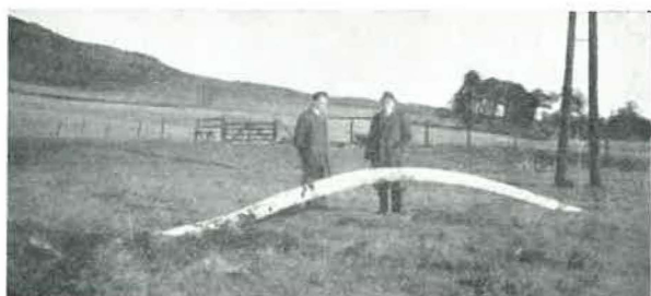
Fig. 2. — Importantes conduites à gaz en acier poussées hors du sol par compression horizontale.
