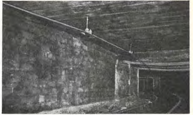
Fig. 5. — Parois latérales et plafond d'un crossing rendu étanche par ce procédé.
