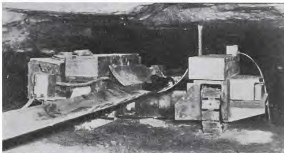
Fig. 11. — La tête sur chenilles du convoyeur développable du B.C.R. de Huntington.
