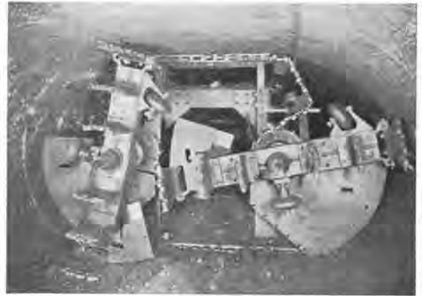
Fig. 2. — L'abatteuse-chargeuse McKinlay.
