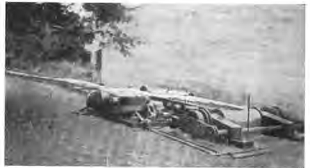
Fig. 3. — Evacuation de gravier de rivière lavé à une distance de 45 mètres, aux essais.
