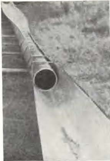
Fig. 4. — Préconformation en auget de la bande métallique par courbure autour d'un tuyau de 30 cm.
