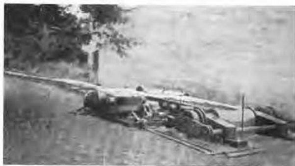
Fig. 3. — Evacuation de gravier de rivière lavé à une distance de 45 mètres, aux essais.
