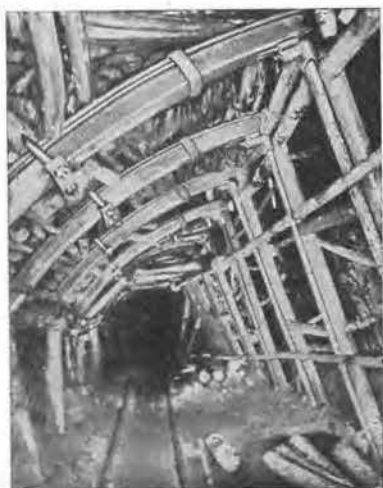
Fig. 95. — Combinaison «Lorenz Toussaint» gisement en dressant à 70° à 90°.
