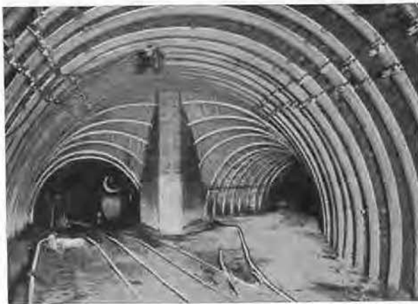
Fig. 89. — Bifurcation avec revêtement en cadres Toussaint-Heintzmann.
