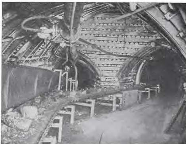
Fig. 56. — Les deux brins passent dans deux galeries distinctes; on remarque à droite une tête motrice actionnant un seul brin (Friedrich der Grosse (Ruhr)).
