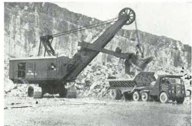
Fig. 2. — Méthode employée après-guerre pour l'exploitation de la carrière montrée à la figure 1. Excavateur électrique remplissant une remorque de 10 tonnes de capacité, tirée par tracteur.
