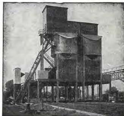
Installations de manutention et distribution de charbon.
