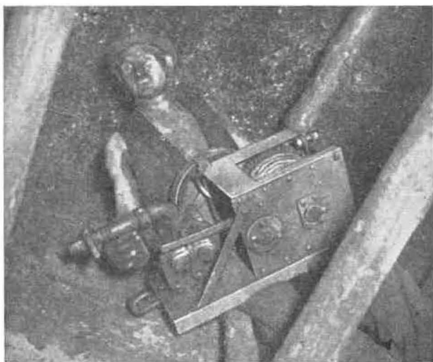
Fig. 34. — Le treuil portatif « Beien » de 57 kg.
