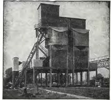
Installations de manutention et distribution de charbon.
