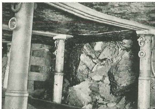
Fig. 5. — Combinaison d'étauçons hydrauliques et de piles pour former une ligne de cassage au remblai.
