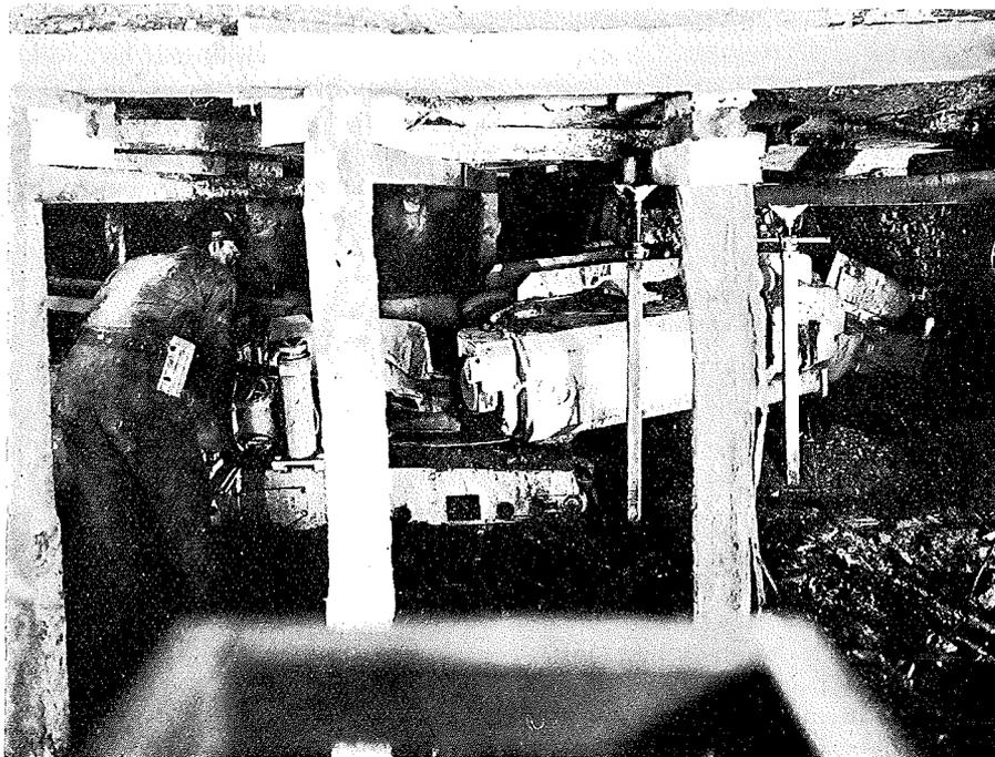
Fig. 4. — La machine entame une nouvelle chambre dans une couche du gisement de Pittsburgh.
