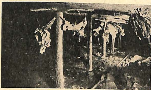
Fig. 4. — Arrêt — Barrage ayant coupé net une explosion en route.
