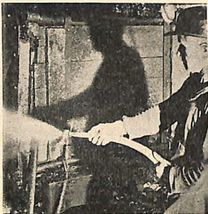
Fig. 6. — Arrosage du front de taille.
