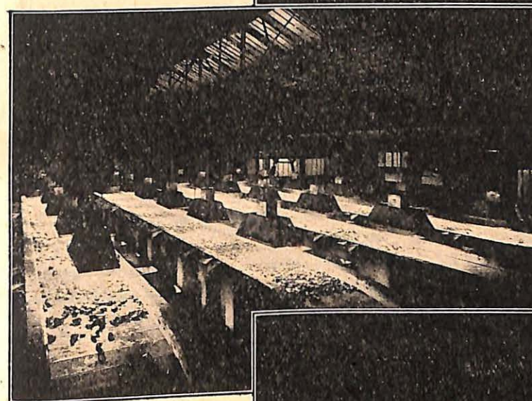
ECLAIRAGE D'UNE INSTALLATION DE TRIAGE (mercure)
