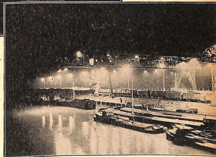
ECLAIRAGE D'UN PORT CHARBONNIER (sodium)
