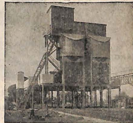
Installation de manutention et distribution de charbon.
