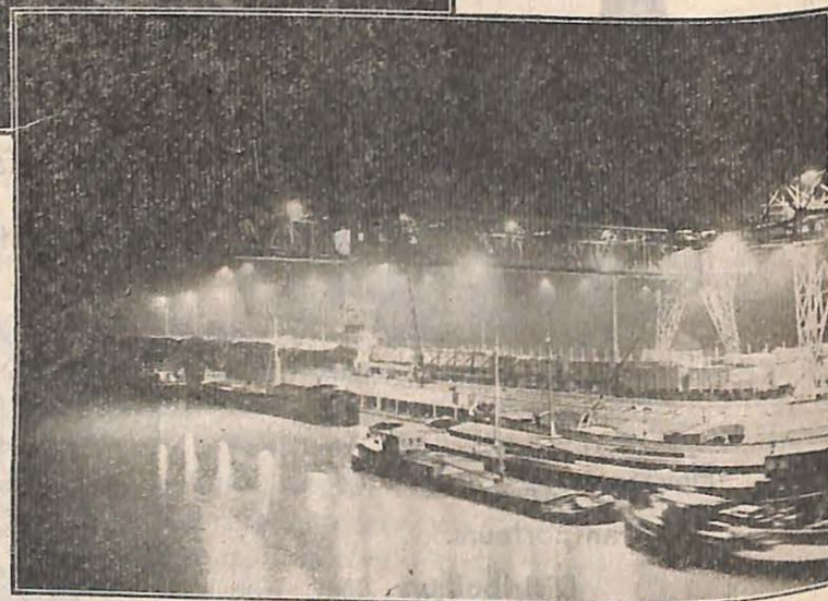
ECLAIRAGE D'UN PORT CHARBONNIER (sodium)
