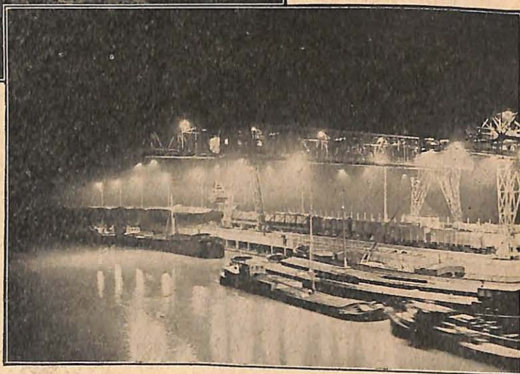
ECLAIRAGE D'UN PORT CHARBONNIER (sodium)
