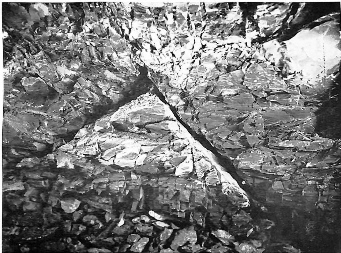
Fig. 10 — Trièdre de roche, dans le toit.
