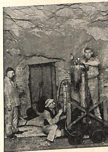
Fig. 1. — Chambre d'explosion. Dispositif de remplissage.
