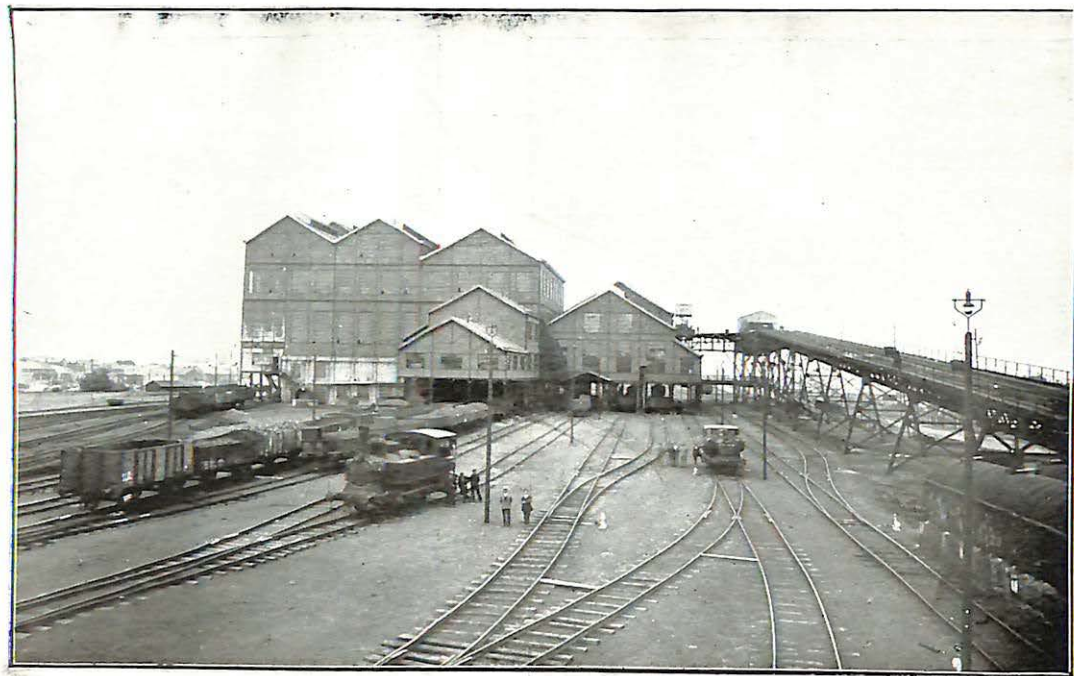
Charbonnages de Mariemont-Bascoup Triage-lavoir de la section de Bascoup. Vue d'ensemble.
