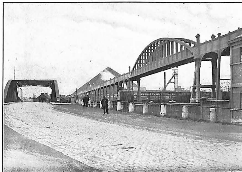
Estacade en béton avec ponts sur la Sambre et sur la route entre les puits et le triage.
