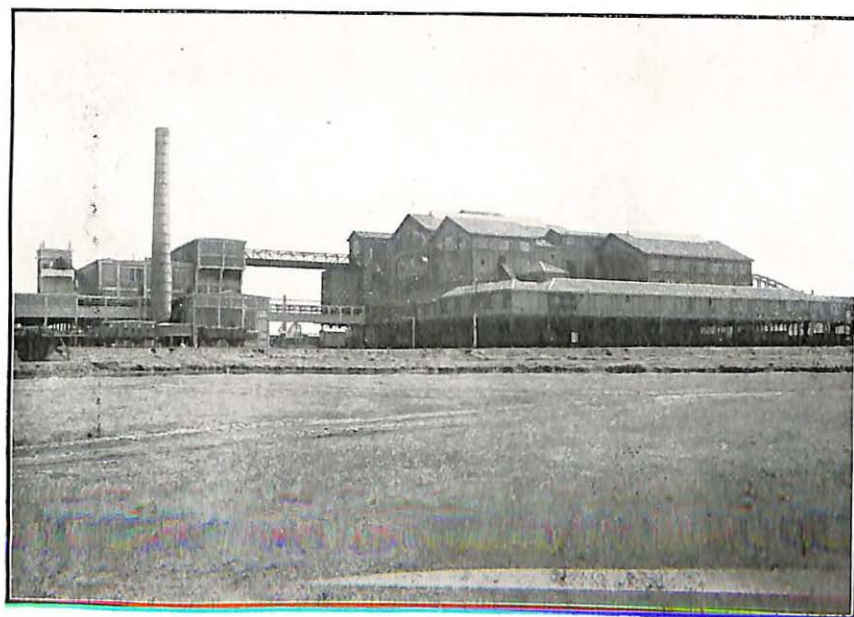
Vue générale des installations.
