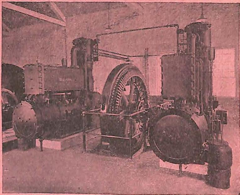
Compresseur d'air Jumelé Sullivan WN-4 à attaque directe par moteur électrique synchrone
