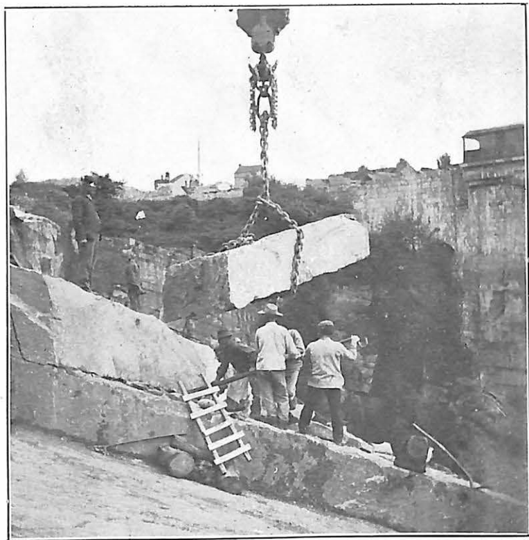
CARRIÈRES VAN ROGGEN, A SPRIMONT — EXTRACTION DES BLOCS.
