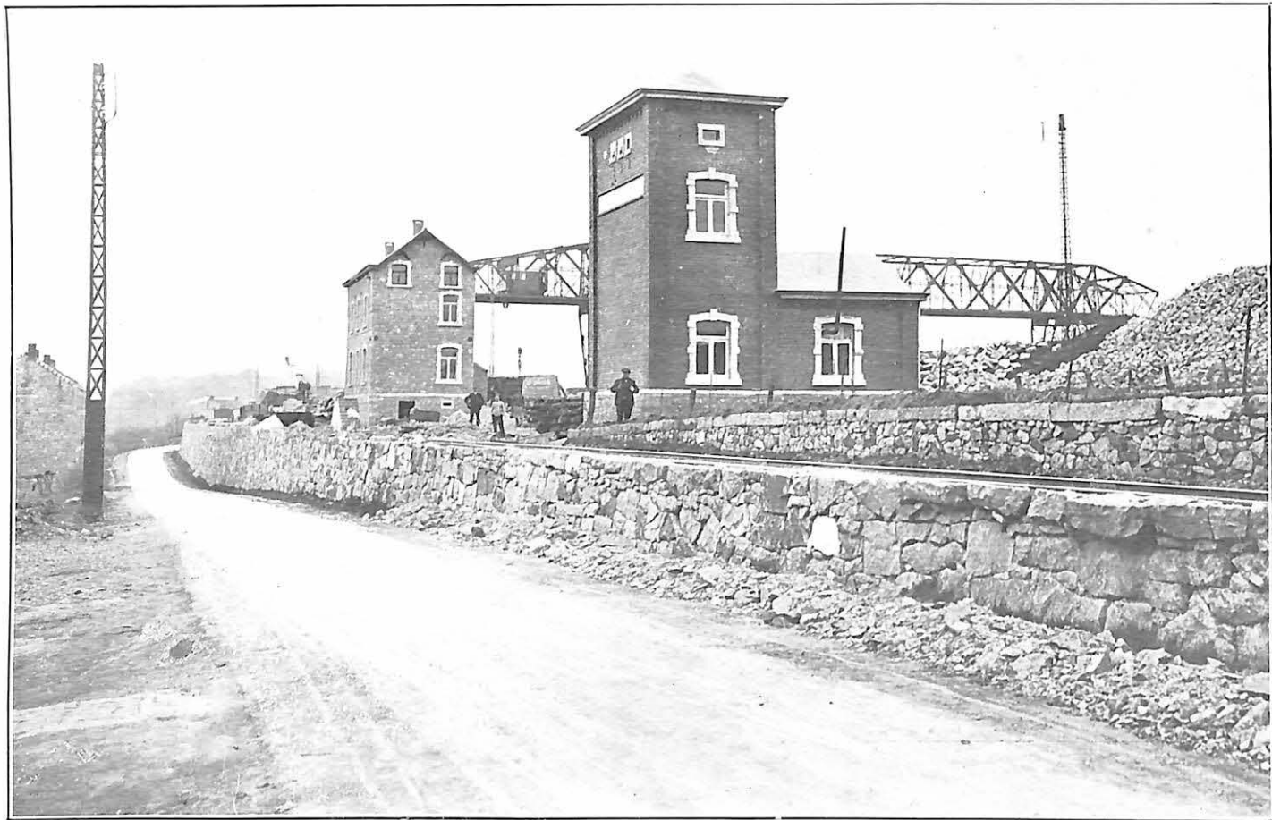
CARRIÈRE TASSIN FRÈRES A ANTHISNES. — CABINE DE TRANSFORMATION.
