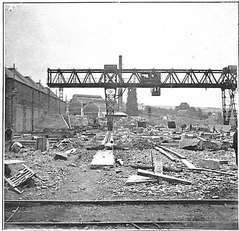
CARRIÈRES VAN ROGGEN, A SPRIMONT — MANUTENTIONS SUR CHANTIER.
