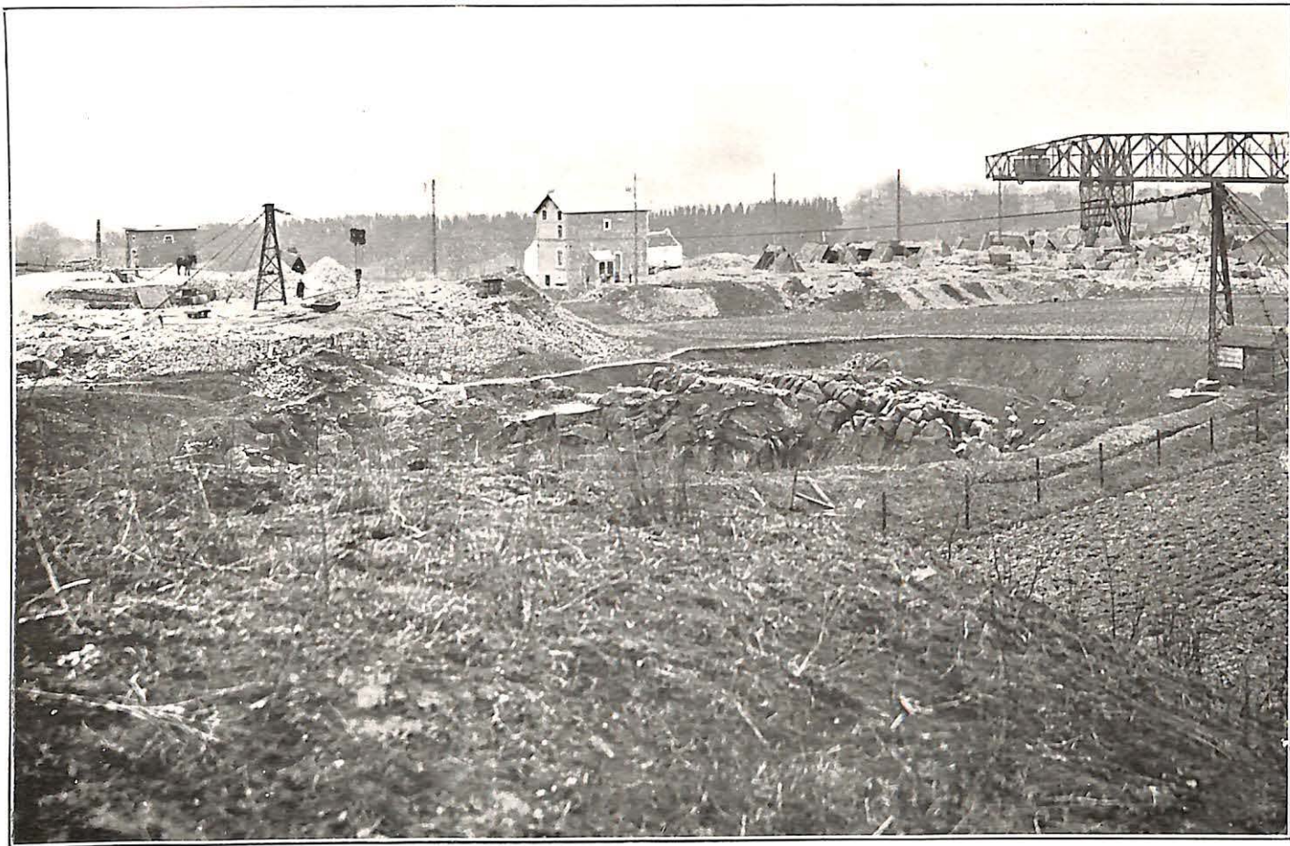
VUE GÉNÉRALE DE LA CARRIÈRE TASSIN FRÈRES A ANTHISNES.
