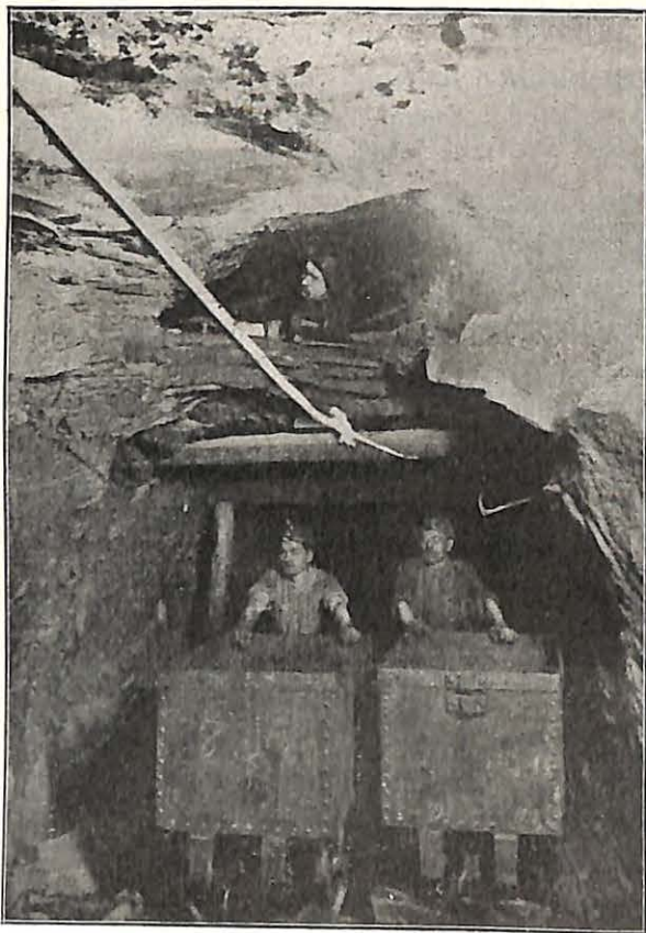
FIG. 8. — Havage et abatage au pic.
