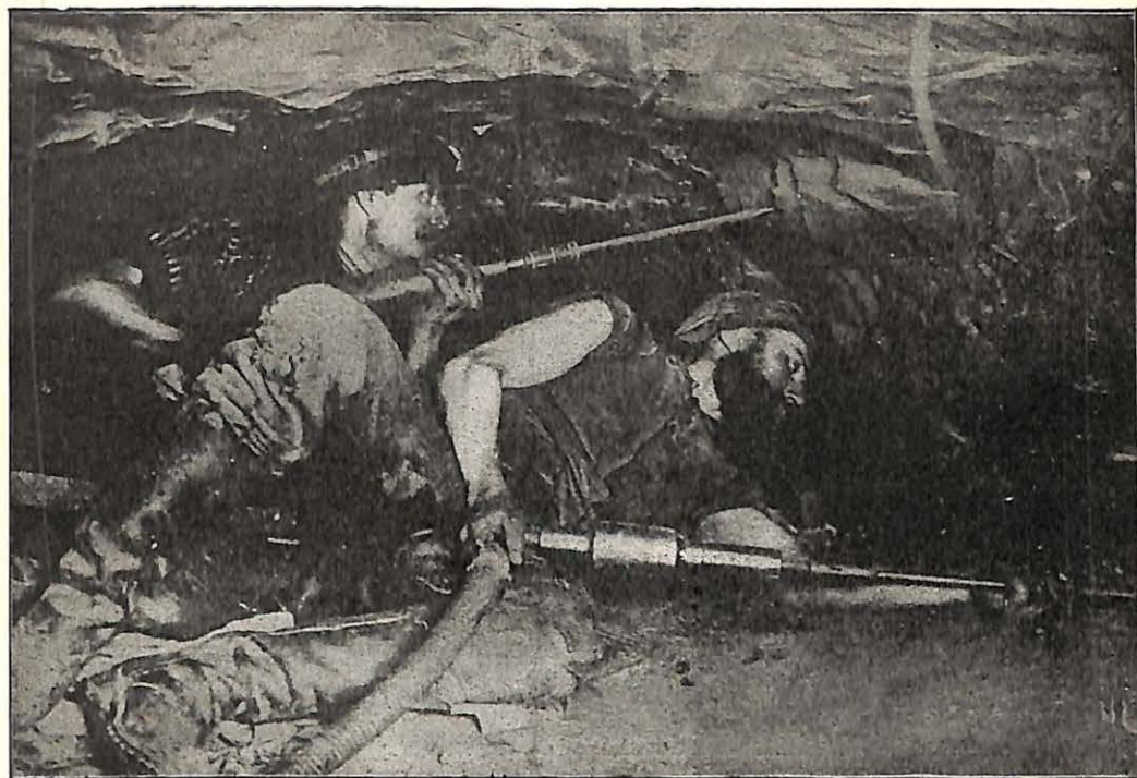
FIG. 9. — Creusement des trous de mine.
