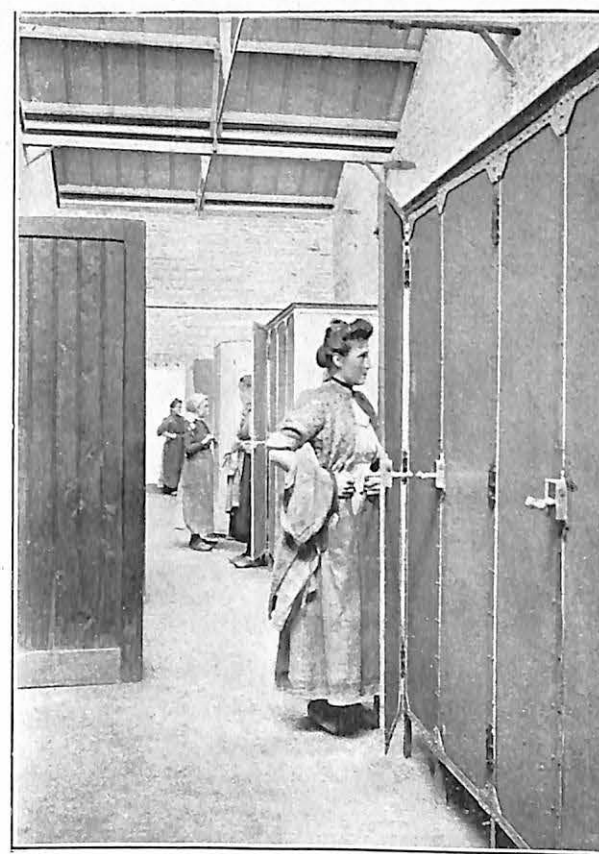
SIÈGE BONNE-ESPÉRANCE. Cabines-douches pour le personnel féminin de la surface.
