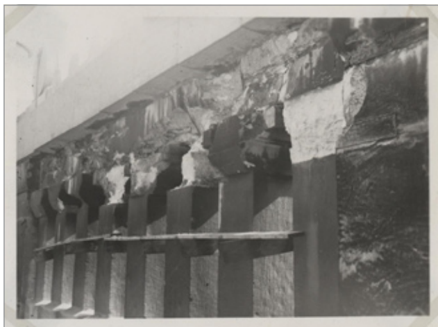
Afbeelding 55 Verweerde Franse steen van Tercé, Justitiepaleis, Brussel (Camerman, s.d.).
