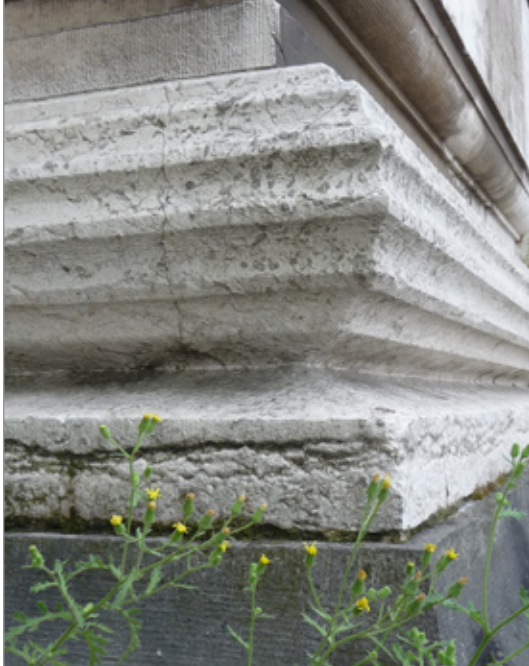
Afbeelding 46 Justitiepaleis Brussel: Comblanchien sokkel .
