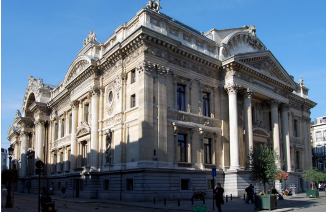
Afbeelding 44 De Beurs is ontworpen in eclectische stijl door architect Suys en uitgevoerd in de periode 1868-1873. Hierbij werden zowel zachte als harde Franse kalksteensoorten gebruikt (Château-Landon, Larrys, Ravières, Saint-Leu, Saint-Maximin en Saint-Vaast, Savonnières) naast Engelse Portland.
