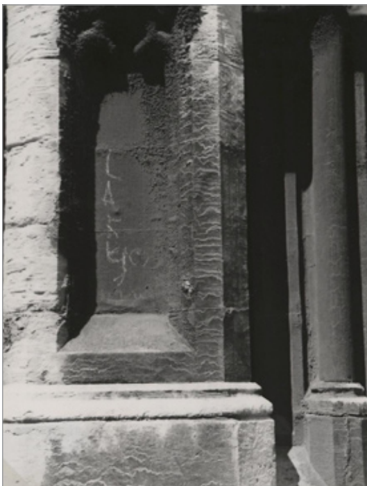
Afbeelding 54 Verweerde Gobertange steen, Sint-Goedelekathedraal, Brussel (Camerman, s.d.).
