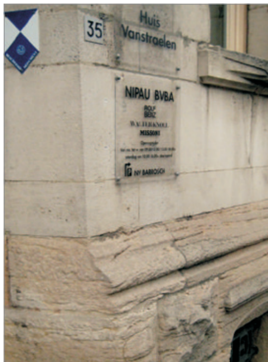
Afbeelding 2 Combinatie van Euvillesteen (boven) en Pouillenaysteen (onder) in een twintigste-eeuws pand in Hasselt.
