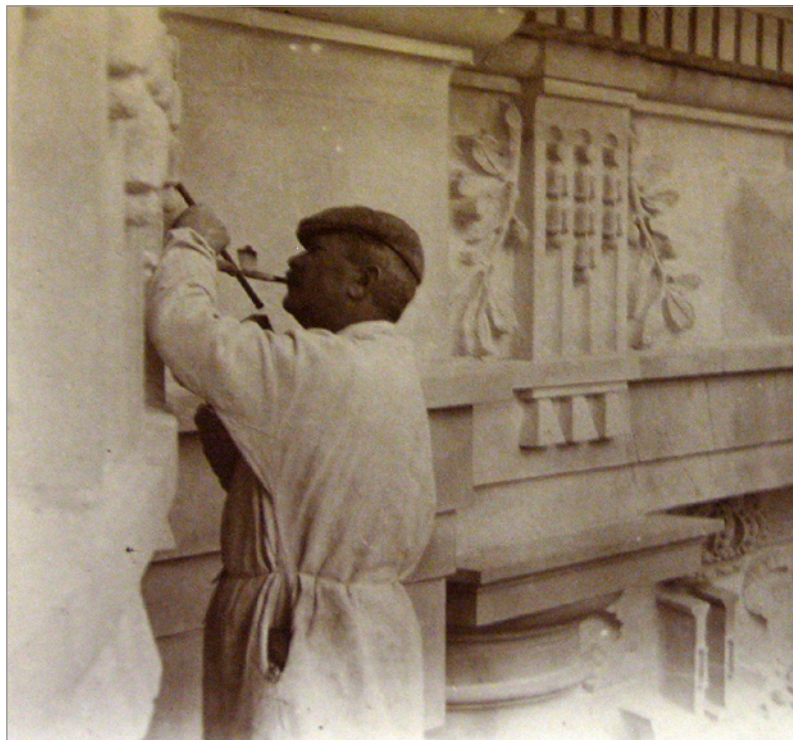
Afbeelding 8 Massieve blokken natuursteen werden in de gevel ingemetseld en nadien door beeldhouwers afgewerkt (foto's: Archief KMMA).
