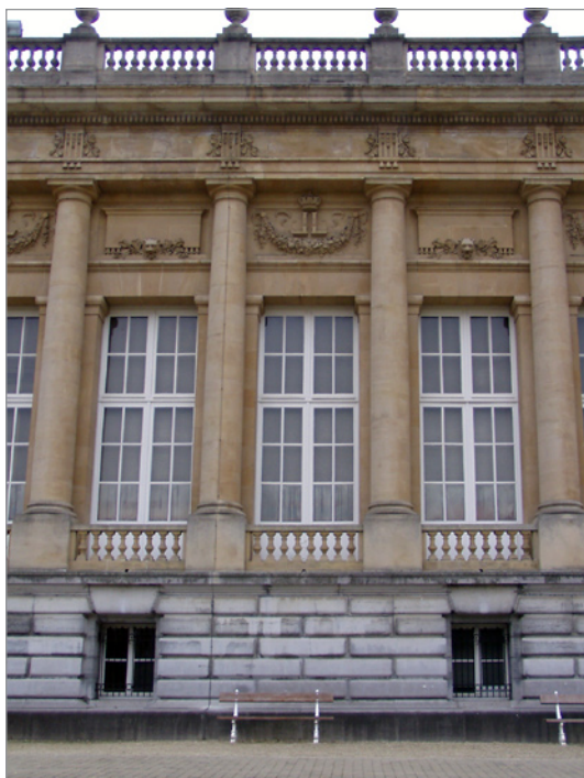
Afbeelding 1 KMMA, voorgevel in Luxemburgse zandsteen tussen sokkel en nok in Belgische Blauwe Hardsteen (foto: M. Dusar).
