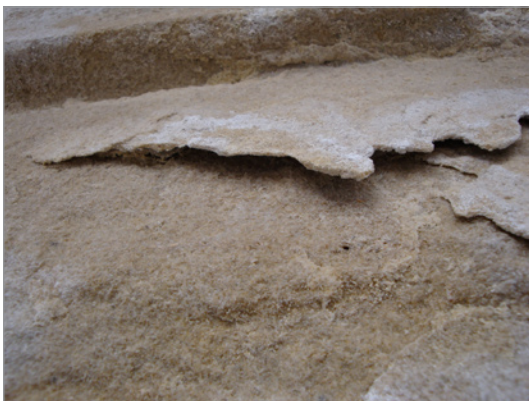
Afbeelding 14 Afstoting van een oppervlaktelaag van een steenblok van het geveldeel onder de kroonlijst. Tussen de afgestoten oppervlaktelaag en de ondergrond bevindt zich een holte (foto: H. De Clercq).
