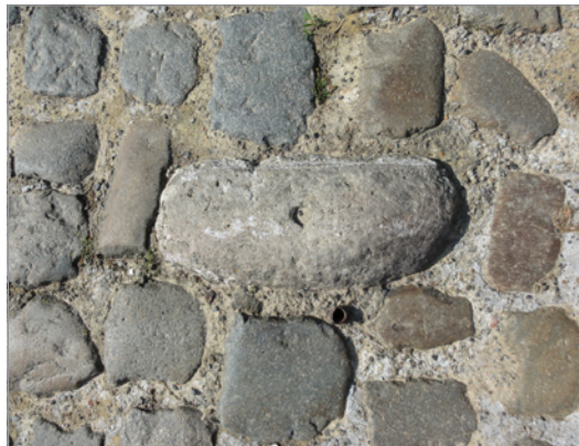
Afbeelding 15 Kasseisteen in Ledesteen met steungat voor poort tussen porfierkasseien te Roborst (Zwalm).
