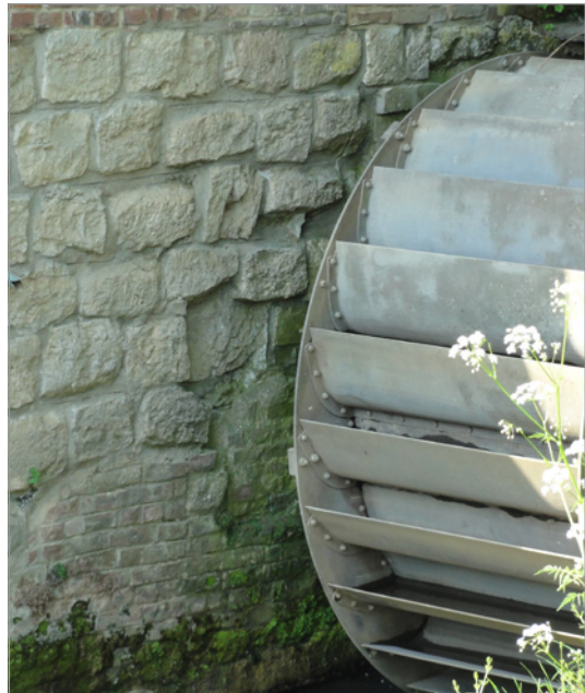
Afbeelding 11 Watermolen te Zwalm (Pede's molentje), met keermuur in Ledesteen.
