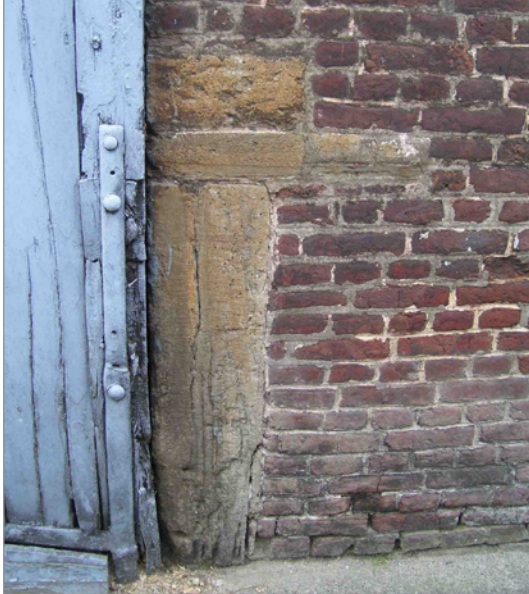
Afbeelding 12 Nummulietenkalksteen gebruikt bij de boerderij te Appelterre.
