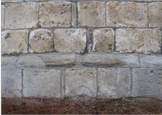
Afbeelding 9 Kerkmuur in Ledesteen met plintlijst in leperiaanse kalksteen (Sint-Bavokerk, Mere).
