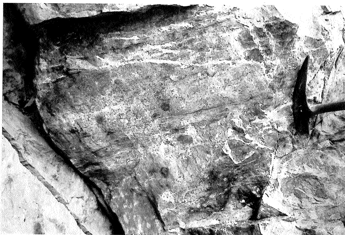
Photo 4. Roche ignée affleurant dans la carrière NW. Vue rapprochée montrant des enduits pelliculaires de malachite et d'oxydes de fer sur une diaclase avec stries de glissement subverticales.
