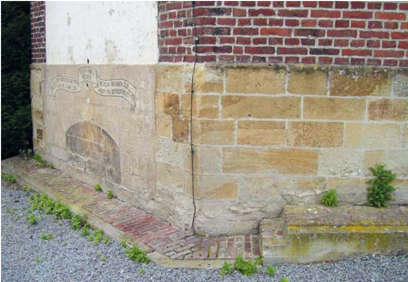
AFBEELDING 8. | Ieperiaanse steen met typisch roestbruine verkleuring. Sint-Magdalenerkerk te St. Maria Lierde.
