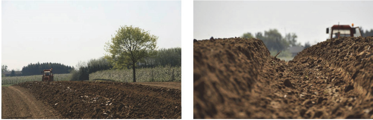
Fig. 2. Aanleg van de keverbank te Rotem in het voorjaar van 2010.
