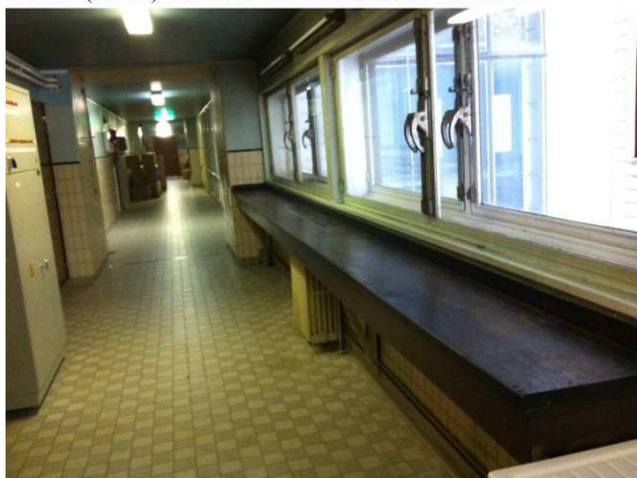
Après (2012) : couloir dégagé.
