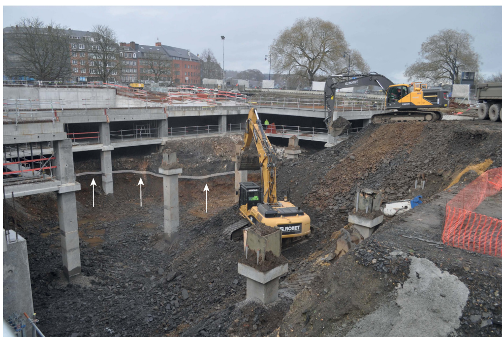
Fig. 4 – Le Grognon à Namur : terrassements des 35.000 m 3 du parking, sous la dalle de l'étage -1. Les niveaux préhistoriques de la zone basse sont indiqués par la ligne claire et les flèches blanches. Photos D. Bosquet, © AWaP.
