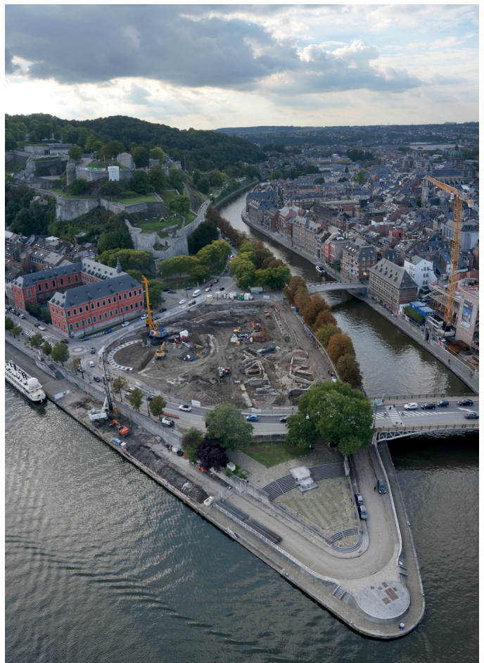
Fig. 1 – Le Grognon à Namur, à la confluence de la Sambre (à droite de la vue) et de la Meuse (photo P.-M. Warnier, © SPW-TLPE-DIGIT).
